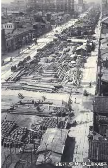
昭和7年頃：地下鉄工事の様子
